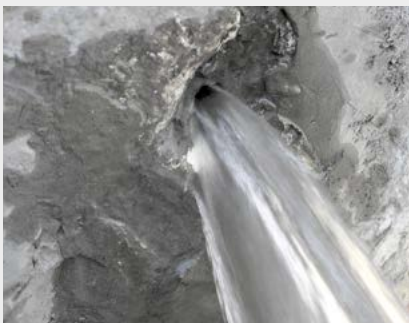
Eine Fließstelle wird mit KÖSTER Kellerdicht 2 Blitzpulver blitzschnell und dauerhaft abgedichtet.
