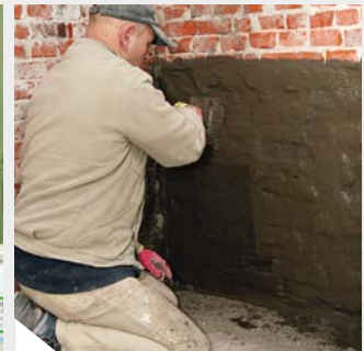
KÖSTER Kellerdicht 1 Schlämme: 2 Anstriche (zweite Lage nach 30 Minuten)
