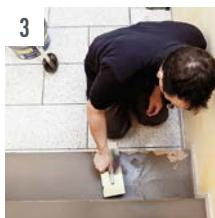
3 Die Masse mit der Glättkelle gleichmäßig bis zur gewünschten Schichtdicke auf den Untergrund auftragen. Nach ca. 15 Minuten\* kann UZIN NC 880 NEU nachgearbeitet oder geglättet werden, nach ca. 30 Minuten\* ist die Fläche belegereif.
