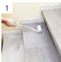
1 Calciumsulfatestriche und Gipsspachtelmassen sowie stark saugende, sandende Untergründe mit der Universalgrundierung UZIN PE 360 PLUS grundieren.
