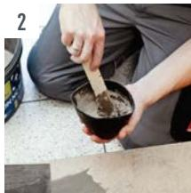
2 Größere Unebenheiten oder Rauigkeiten in der Oberfläche mit standfester Turbo Spachtelmasse UZIN NC 880 glätten. Dazu kaltes, klares Wasser in sauberen Behälter geben. Pulver unter kräftigem Rühren einstreuen und klumpenfrei anrühren. Nur soviel Mörtel anmischen, wie innerhalb der Verarbeitungszeit von 5–10 Minuten verarbeitet werden kann.
