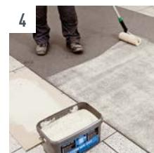
Den lösemittelfreien Kontaktklebstoff UZIN WK 222 mit beigelegter gelber UZIN Schaumstoff-Rolle grob, sowie an den Ecken und Kanten mit dem UZIN Silikonpinsel gleichmäßig dünn auf das zu verklebende Material und den Untergrund auftragen. Beim Auftragen des Klebstoffs mit der mitgelieferten 25 cm Rolle empfiehlt sich die Vorverteilung auf einem Stück Spanplatte o.ä. zur gleichmässigen Benetzung der Rolle.
